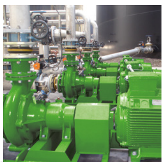
MAGNUM SX Pompa per sostanze dense, con motoriduttore e cuscinetto portante
